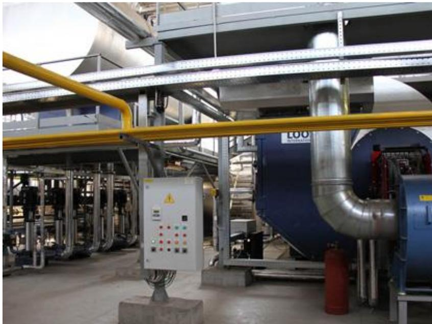
Диапазон производительности модульных котельных нашего производства составляет 0,1 – 20 МВт. Модульная котельная в готовом виде – это одно здание, не имеющее внутренних перегородок и собранное из отдельных блок-модулей (их количество может быть разным).
